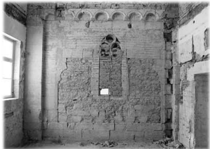
Die Westwand der Brunnenkapelle nach der Freilegung Ende 2003 Foto: BLFD
